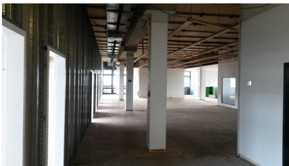
Bild 7 – Provisorium 2.9, AC 4.OG Flurseite
