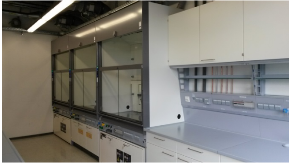
Bild 5 – Provisorium 1.3, AC Sockelgeschoss
