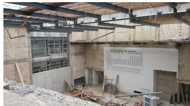
Bild 4 – Alter Hörsaal mit neuem Fenster
